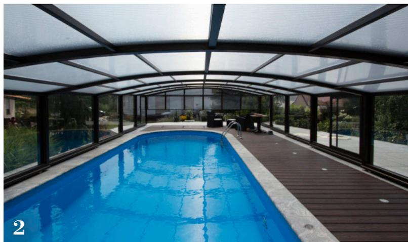
**1** Die Überdachung besteht aus insgesamt sechs Elementen, die sich beim Öffnen und Schließen teleskopartig ineinander schieben. Sie benötigen keine Führungshilfen am Boden, sondern gleiten leicht auf Rollen.
